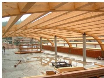
Posa in opera di strutture composte da travi in legno lamellare, prodotte in stabilimento nel rispetto delle normative vigenti sia dal punto di vista strutturale (D.M. 96, D.M. 2005, DIN 1052, EC 5) che del risparmio energetico (D.LGS. 311/2006).
